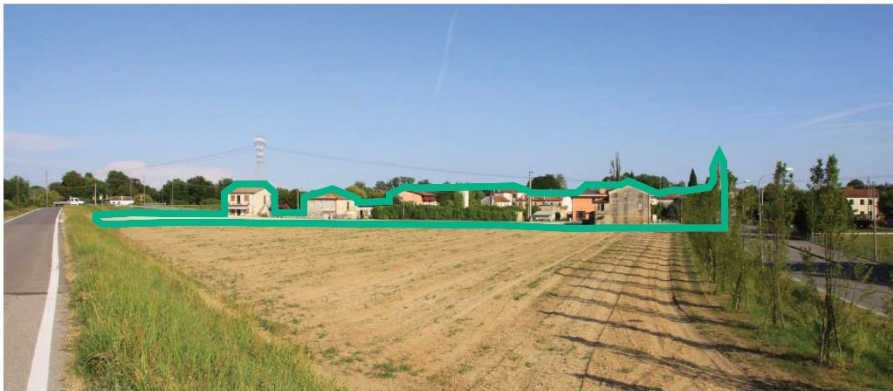
STATO DI FATTO VISTA DAL INCROCIO VIA ENRICO TOTI E STRADA PROVINCIALE 57
